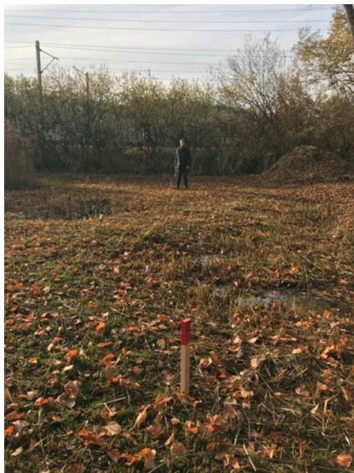
Abb. 4: Vermessungsarbeiten für Visierung der geplanten Weiher im frisch geschnittenen Schilfried (Foto: Pro Natura SGA)
