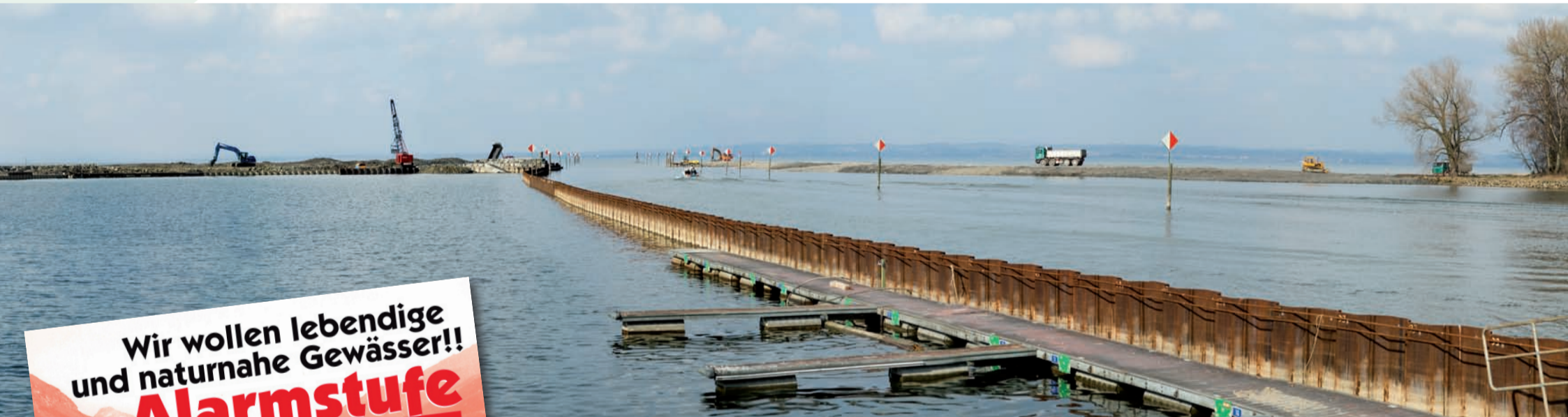
Baustelle Mündung Aare Rhein in den Bodensee bei Altenrhein.
