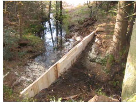
Sperre a am 23.10.07 noch ohne Überdeckung
