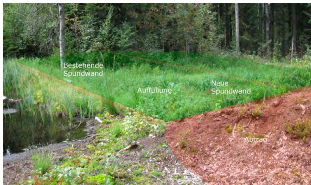
Abbildung 3: Auffüllung zwischen bestehender und neuer Spundwand Süd. In Grün ist die Fläche der Auffüllung eingezeichnet.
