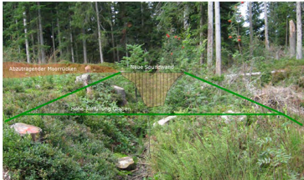
Abbildung 2: Blick auf den Graben aus nordöstlicher Richtung: Die Spundwände (eingezeichnet ist nur die im Nordwesten liegende) werden das Wasser aus dem Hochmoor auf der linken Seite in die im Norden anschließende Moorfläche lenken.
