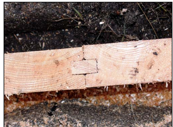
Abb. 15 und 16: Details zum Rammvorgang und zur Konstruktion. Alle Bohlen waren beidseits genietet. Zur Abdichtung wurde eine separate Feder eingelegt und befestigt. Diese Vorgehensweise steht im Zusammenhang mit den technischen Möglichkeiten der mit der Holzaufbereitung beauftragten Sägerei. 20.09.2005
