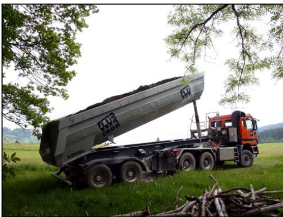
Abb. 5: Die mit den Spundwänden aufgestauten Entwässerungsgräben wurden mit Torf hinterfüllt. Der Torf wurde auf Vermittlung des ARE-SG, Natur- und Landschaftsschutz, vom Kanton Nidwalden zur Verfügung gestellt. Das Bild zeigt das Kippen des Torfes am Zwischendepot. 30.05.2005
