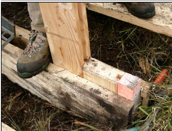
Abb. 15 und 16: Details zum Rammvorgang und zur Konstruktion. Alle Bohlen waren beidseits genietet. Zur Abdichtung wurde eine separate Feder eingelegt und befestigt. Diese Vorgehensweise steht im Zusammenhang mit den technischen Möglichkeiten der mit der Holzaufbereitung beauftragten Sägerei. 20.09.2005
