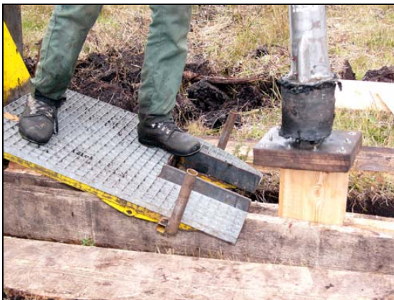
Abb. 19: Mit einer speziell konstruierten Schlagplatte konnte das Zersplittern der Bohlen verhindert werden. 04.10.2005
