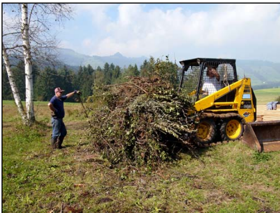
Abb. 7: Im Winter 2004/2005 waren die den Entwässerungsgräben entlang aufgewachsenen Bäume entfernt worden. Nun mussten noch die zahlreichen Sträucher geschnitten werden. Das Schnittgut wurde am Waldrand aufgeschichtet. 22.09.2005
