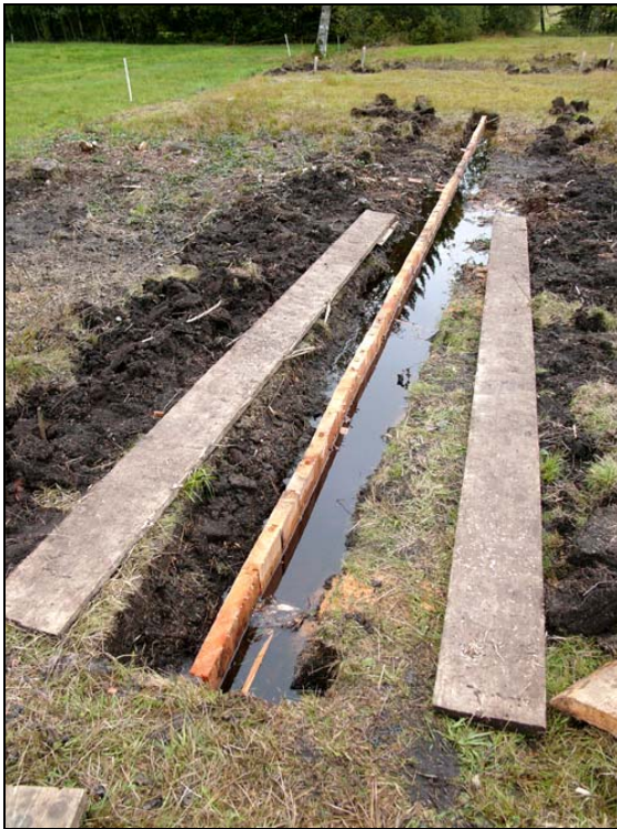
Abb. 22: Nach dem Setzen der Bohlen wurden sie mit der Kettensäge ins Lot geschnitten. Bereits staut sich bergseits das Wasser. Als nächstes wird Torf eingefüllt. 21.09.2005
