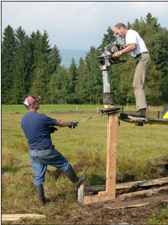
Abb. 18: Die optimale Technik des Einrammens musste an Ort entwickelt werden. Vor allem bei langen Bohlen musste ein Helfer die einzurammende Bohle gegen die Nachbarbohle ziehen, um eine Ausbrechen zu verhindern. 04.10.2005
