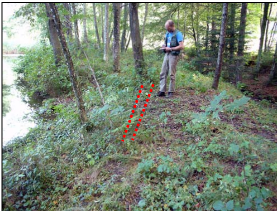
Abb. 28: Dieser Damm des Stauweihers verhinderte bei Hochwasser einen Überlauf ins benachbarte Bächlein, was zur Folge hatte, dass das Hochmoor bei starker Wasserführung überflutet wurde. Im Einvernehmen mit dem Grundeigentümer konnte ein Überlauf eingebaut werden, der ein Überfließen ins Hochmoor verhindern soll. 13.09.2005
