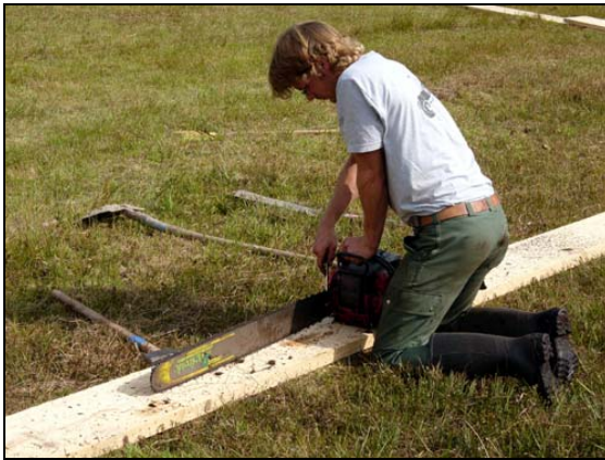
Abb. 8: Mit dieser Kettensäge mit langem Schwert und Chromstahlkette wurden die Spundwände vorgeschritten. Dabei ging es in erster Linie darum, das im Moor liegende Wurzelwerk der Bäume und Sträucher durchzutrennen, um eine Ablenkung der Spundwand-Bohlen zu verhindern. 15.09.2005
