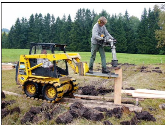
Abb. 17: Auf einem speziell konstruierten Ausleger des Kleintraxes stehend, rammt Markus Preisig mit einem umgebauten Grabenstamper eine Bohle in den Torfuntergrund. Es ist ein sehr exaktes Zusammenspiel zwischen dem Traxführer und der Person, die den Grabenstamper führt, erforderlich. 29.09.2005
