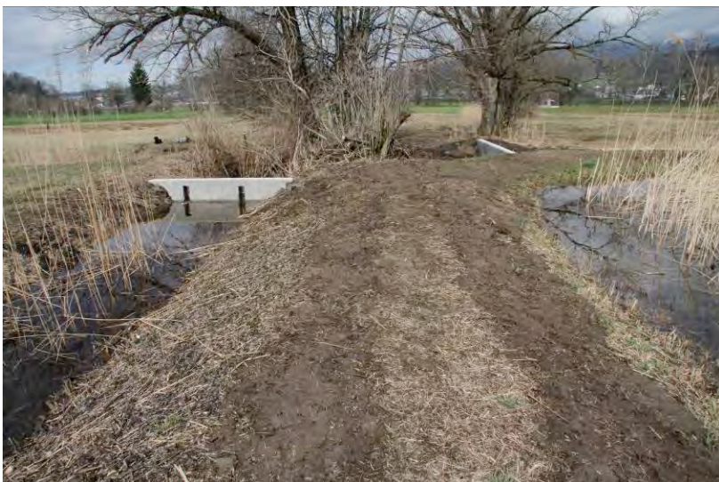
Abb. 9: Standorte der Schieber 2 und 3; rechts im Bild ist ein Ausschnitt der Wasserfläche im Kaltbrunner Riet sichtbar; aus dieser Fläche heraus wird der Hüttengraben (links) alimentiert. Es ist deshalb erforderlich, auch im Riet selbst einen ausreichend hohen Wasserstand zu halten. Dieser Zustand wird durch einen bereits 2009 eingebauten Schieber im nordöstlich des Hüttengrabens liegenden Weidengraben erreicht.
