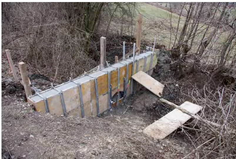
Abb. 6: Am Schieber 1 sind die Betonarbeiten fertig gestellt
