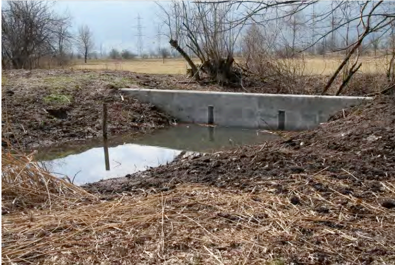
Abb. 7: Schieber 2 ist fertig gestellt und bis zu den Überläufen aufgestaut.
