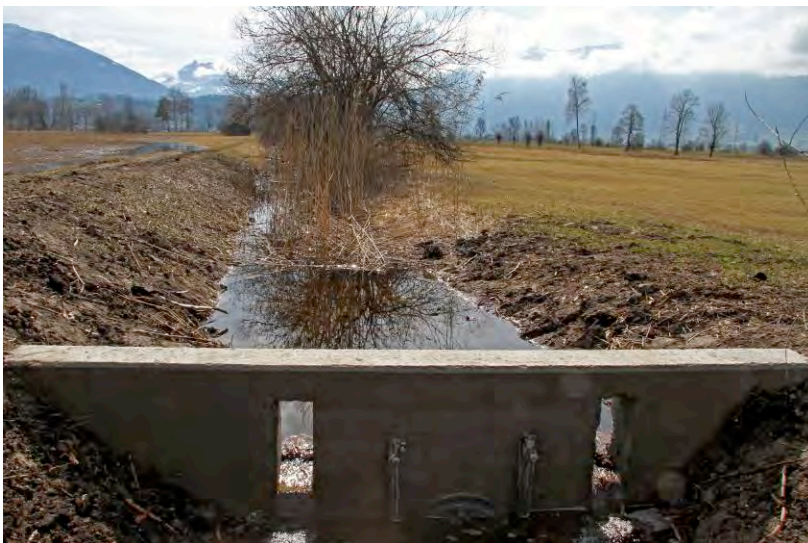
Abb. 8: Schieber 3 ist fertig gestellt und bis zu den Überläufen aufgestaut.
