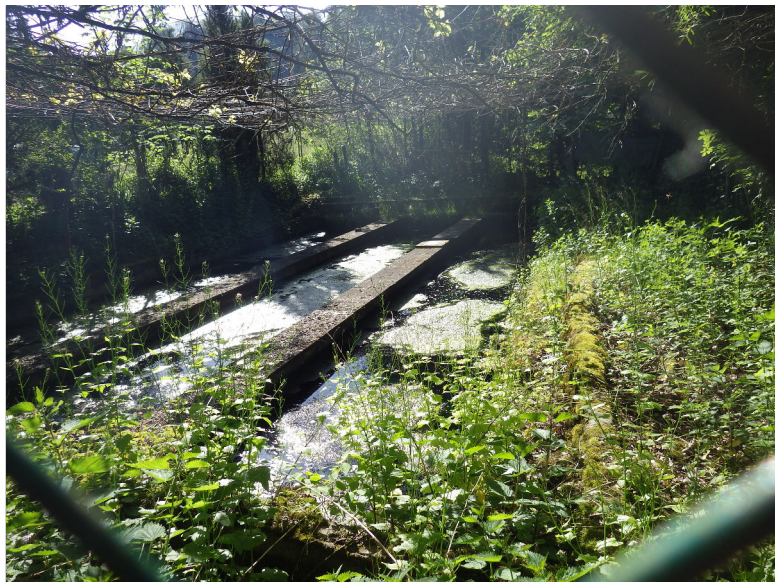
Foto Nr. 6: Fischzuchtbecken Schättin: Umwandlung in Amphibientümpel (separates Projekt)
