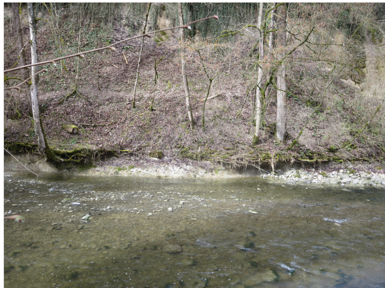
Foto Nr. 6: Die Wurzelstrukturen der Bäume deuten auf eine markante Eintiefung der Sohle um mindestens 0.5 m in den letzten Jahrzehnten hin
