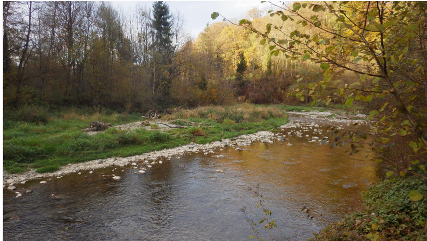
Foto Nr. 1: Flussschleufe Wilenholz, Blick flussabwärts
