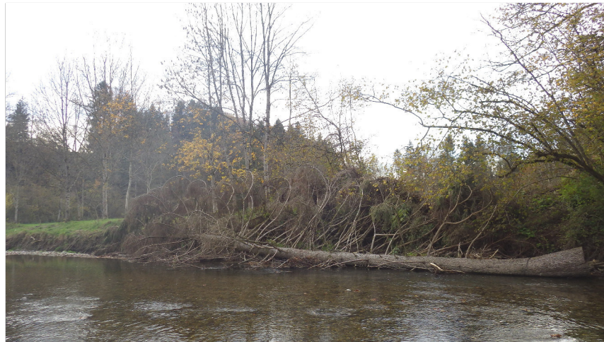
Foto Nr. 7: Vorhandener Uferschutz mit Rauhbaum (rechtsufrig, Seite Oberbüren) zum Schutz landwirtschaftlicher Nutzflächen
