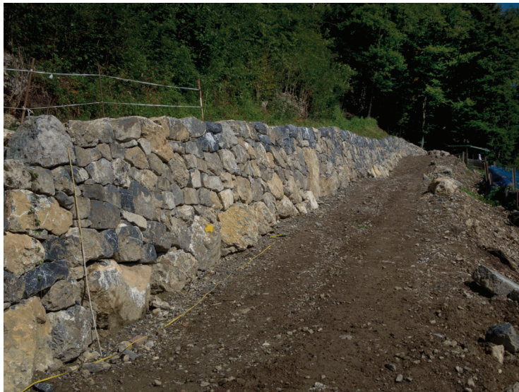
Mauer 1 nach der Sanierung
