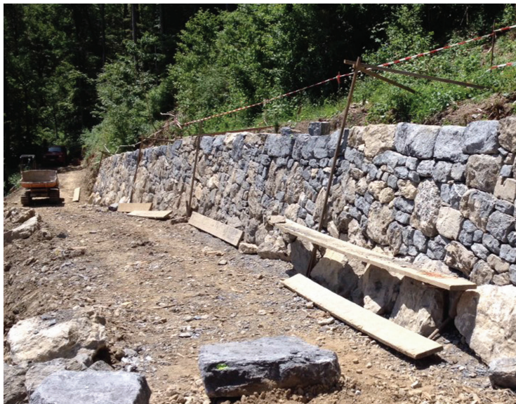
Mauer 1 während dem Bau
