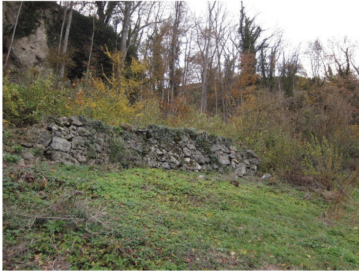
Mauer 1 vor der Sanierung
