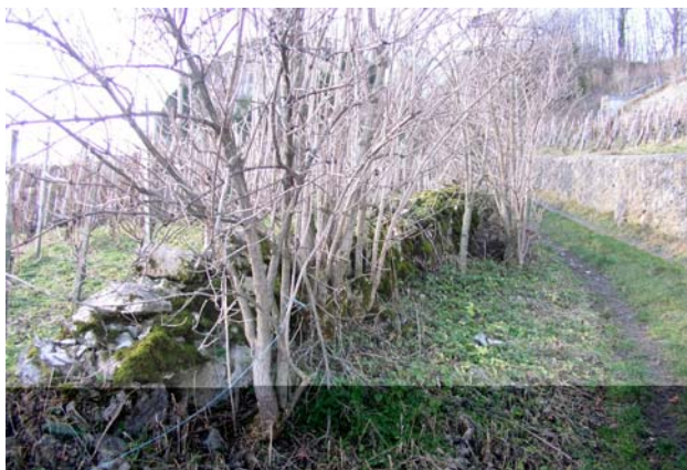
Mauer 20 oben vor der Sanierung
