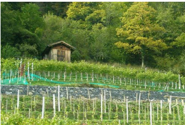
Sanierte Mauer 6 in der Landschaft
