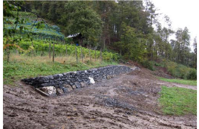
Mauer 2 nach der Sanierung
