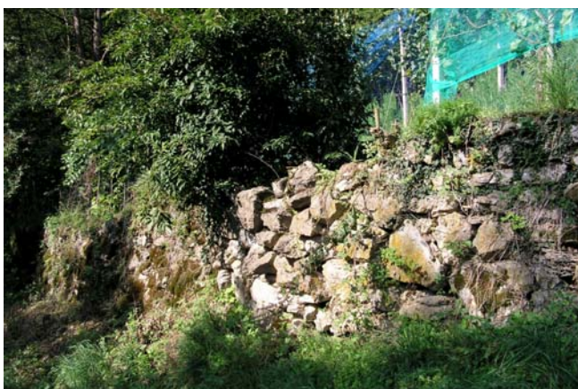
Mauer 5 vor der Sanierung (Sept. 2006)
