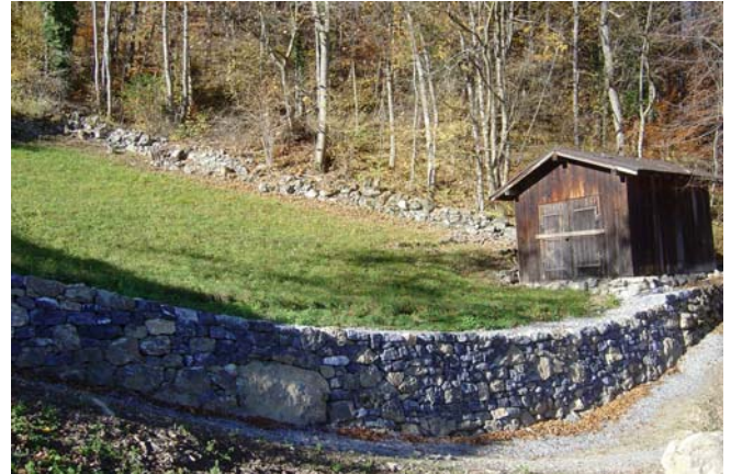
Mauer 1 nach der Sanierung
