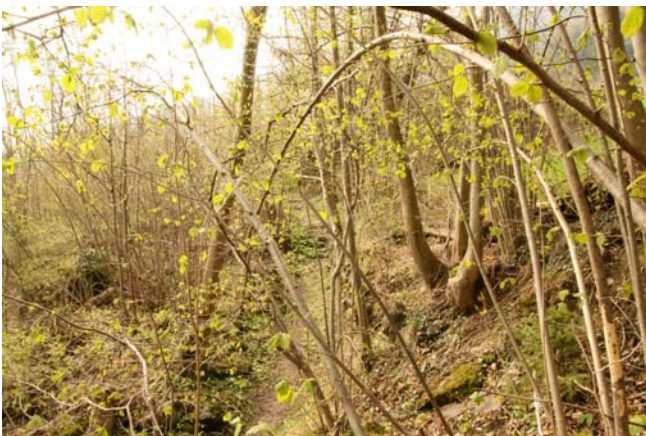
Umgebung von Mauer 1 vor der Sanierung
