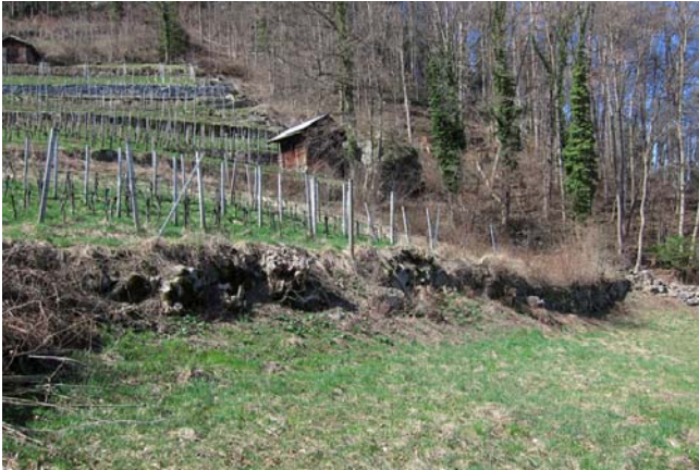
Mauer 2 vor der Sanierung
