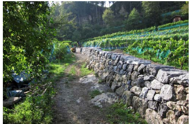
Mauer 3 nach der Sanierung
