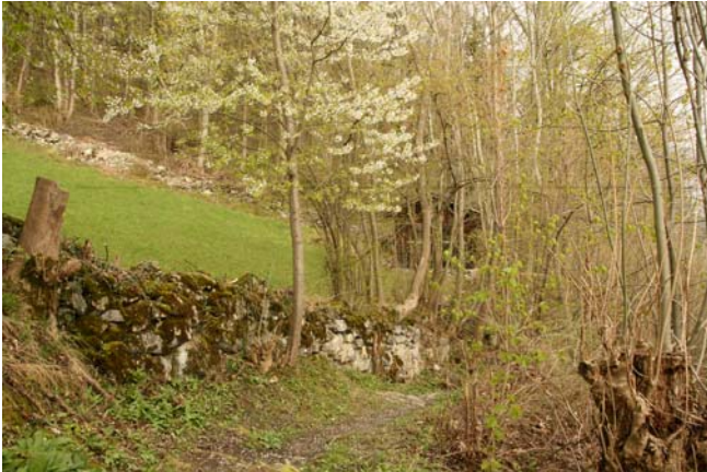
Mauer 1 vor der Sanierung
