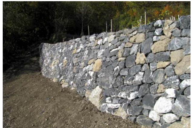
Mauer 4 nach der Sanierung (SUS 2008)
