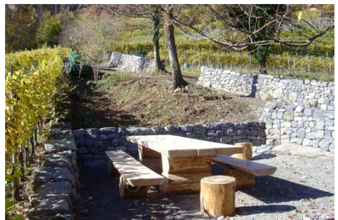
Mauer 4 (Sitzplatz) nach der Sanierung
