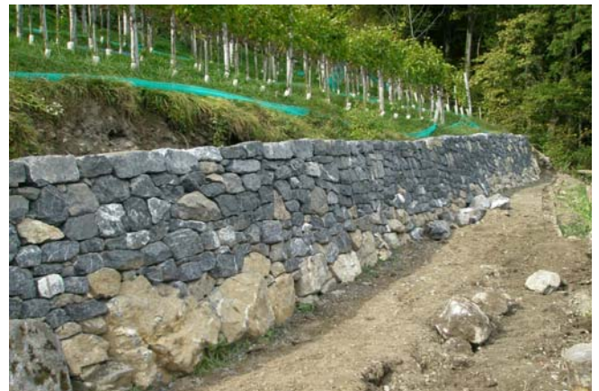
Mauer 6 nach der Sanierung
