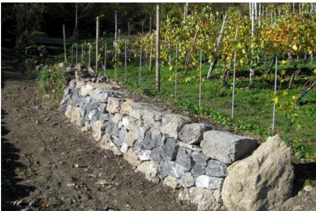
Mauer 3 oben nach der Sanierung (SUS 2008)
