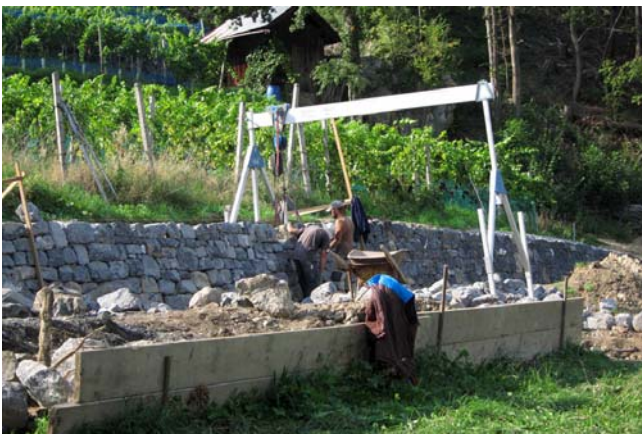
Mauer 2 in der Bauphase
