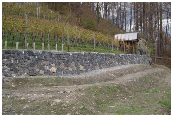
Mauer 7 nach der Sanierung (Nov. 2012)
