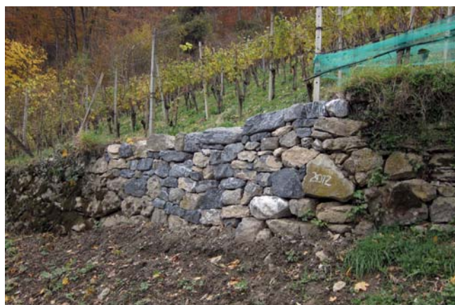
Mauer 5 nach der Sanierung (Nov. 2012)
