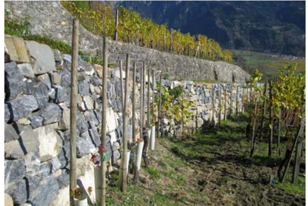
Mauer 22 nach der Sanierung (SUS 2007)
