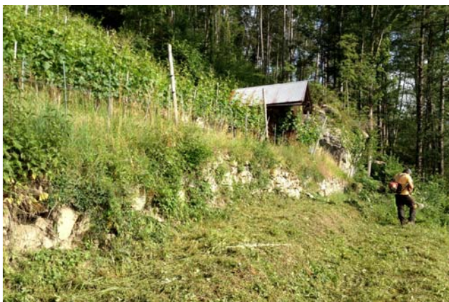
Mauer 7 vor der Sanierung (Juni 2012)
