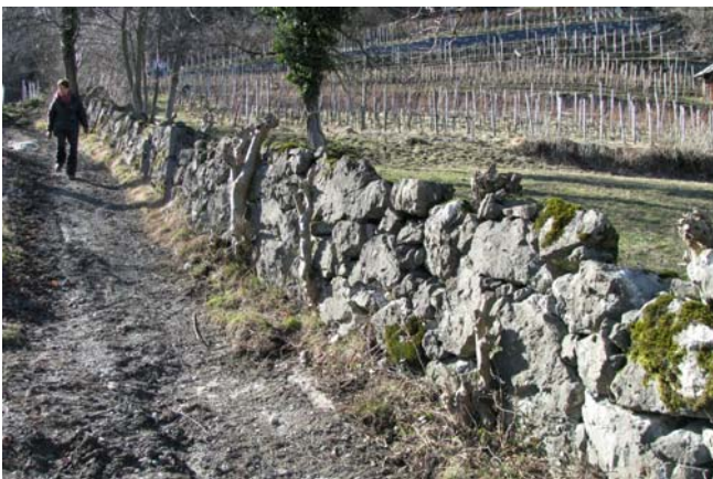
Mauer 3 vor der Sanierung
