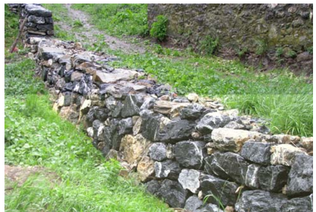
Mauer 20 unten nach der Sanierung (Forstgruppe 2008)
