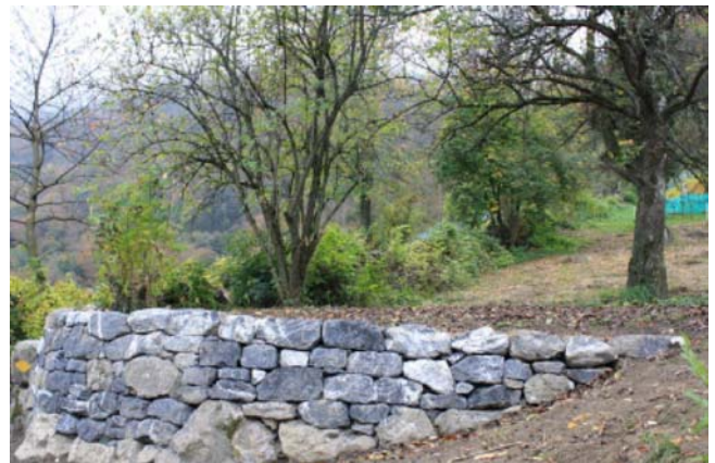
Mauer 3 unten nach der Sanierung (SUS 2008)
