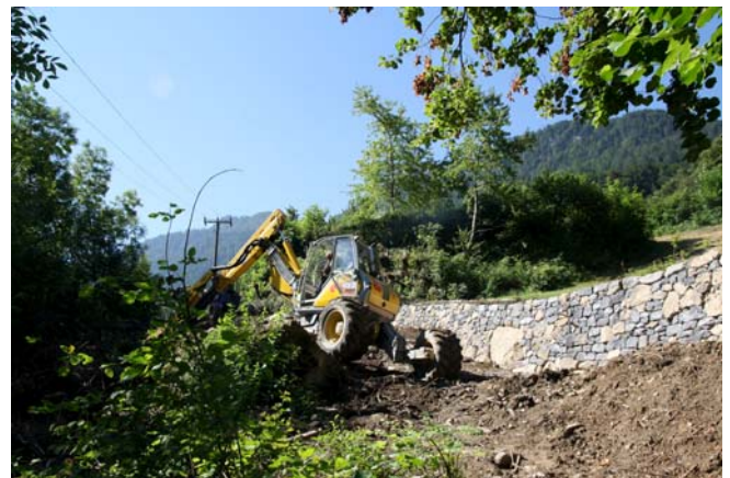
Umgebung von Mauer 1 nach der Sanierung
