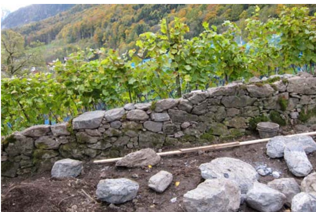
Mauer 4 nach der Sanierung (ausgebessert)
