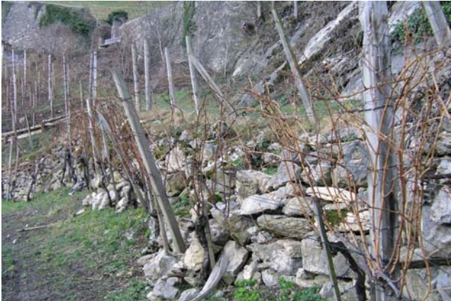
Mauer 22 vor der Sanierung
