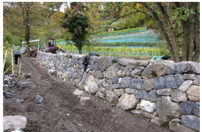
Mauer 3 nach der Sanierung
