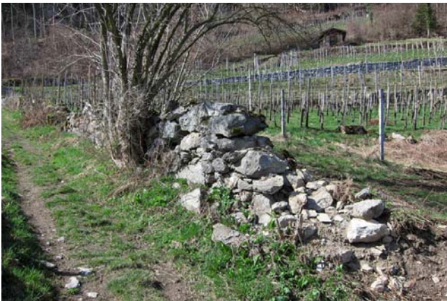
Mauer 3 vor der Sanierung
