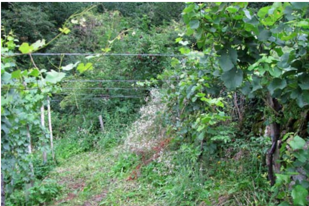
Mauer 4 vor der Sanierung
