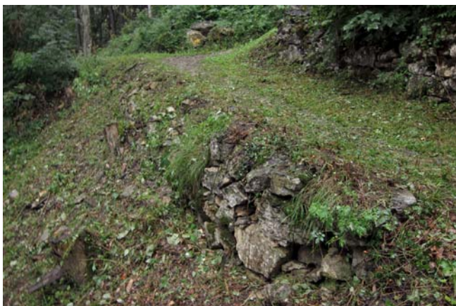
Mauer 10 vor der Sanierung (August 2012)
