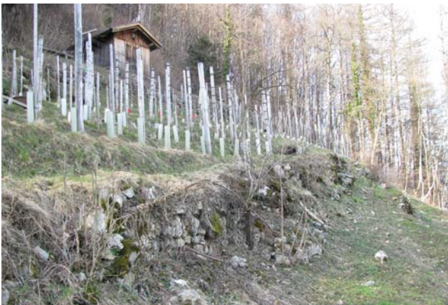
Mauer 6 vor der Sanierung
