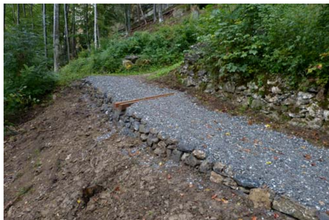
Mauer 10 nach der Sanierung (Sept. 2012)
