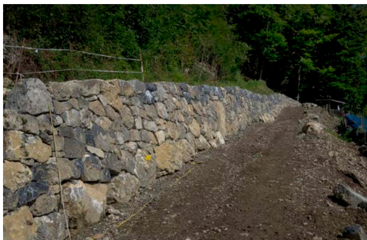
Mauer M1 nach der Sanierung
