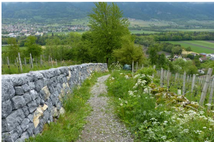
Mauer M3 (rechte Bildseite)
