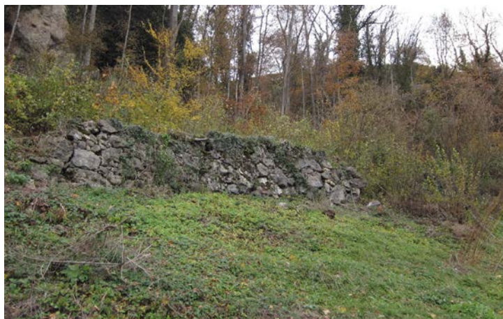
Mauer M1 vor der Sanierung
