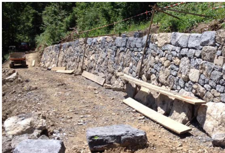
Mauer M1 während dem Bau
