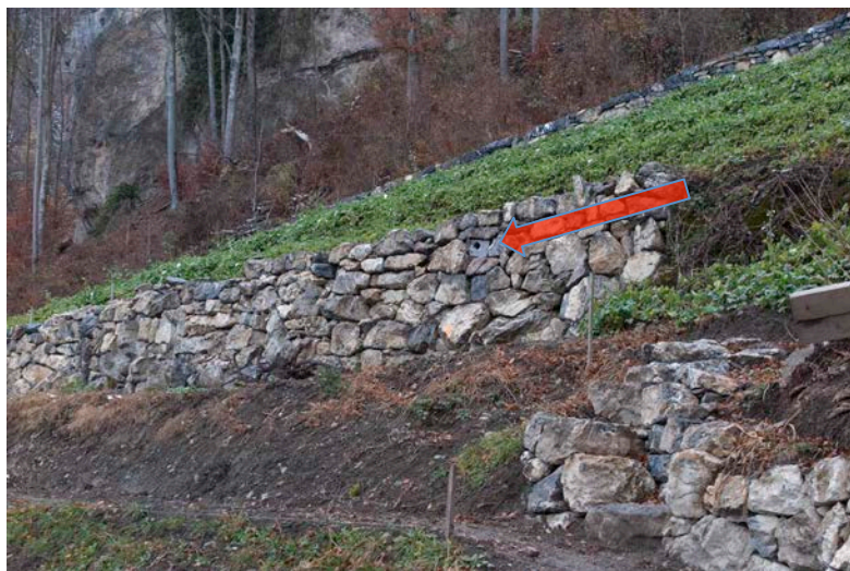
Eingebaute Wiedehopfnische in Trockenmauer Parzelle 1797
