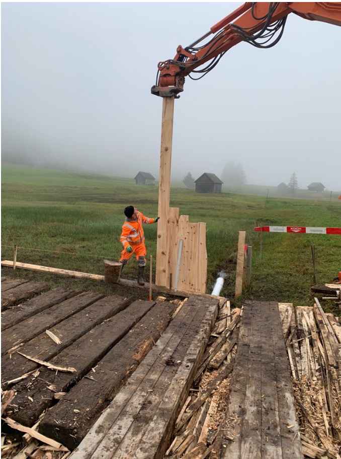
Abbildung 1 Setzen der Spundwand im westlichen Teil der Parzelle 516 als Abschluss der Hochmoorfläche.
