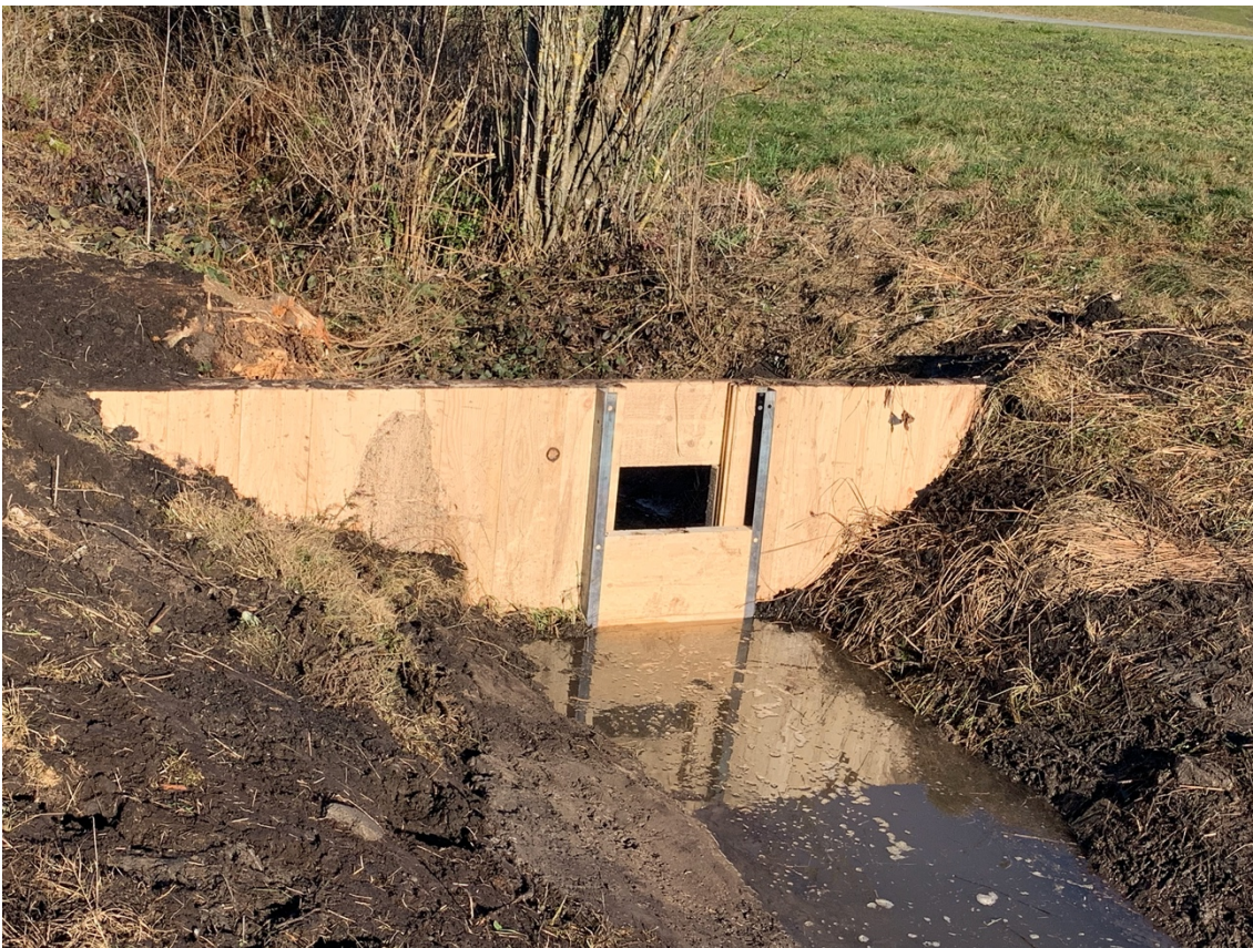
Abbildung 7 Eingebautes regulierbares Wehr zum Aufstau des Wassers und temporären Ablass für die Streumahd.
