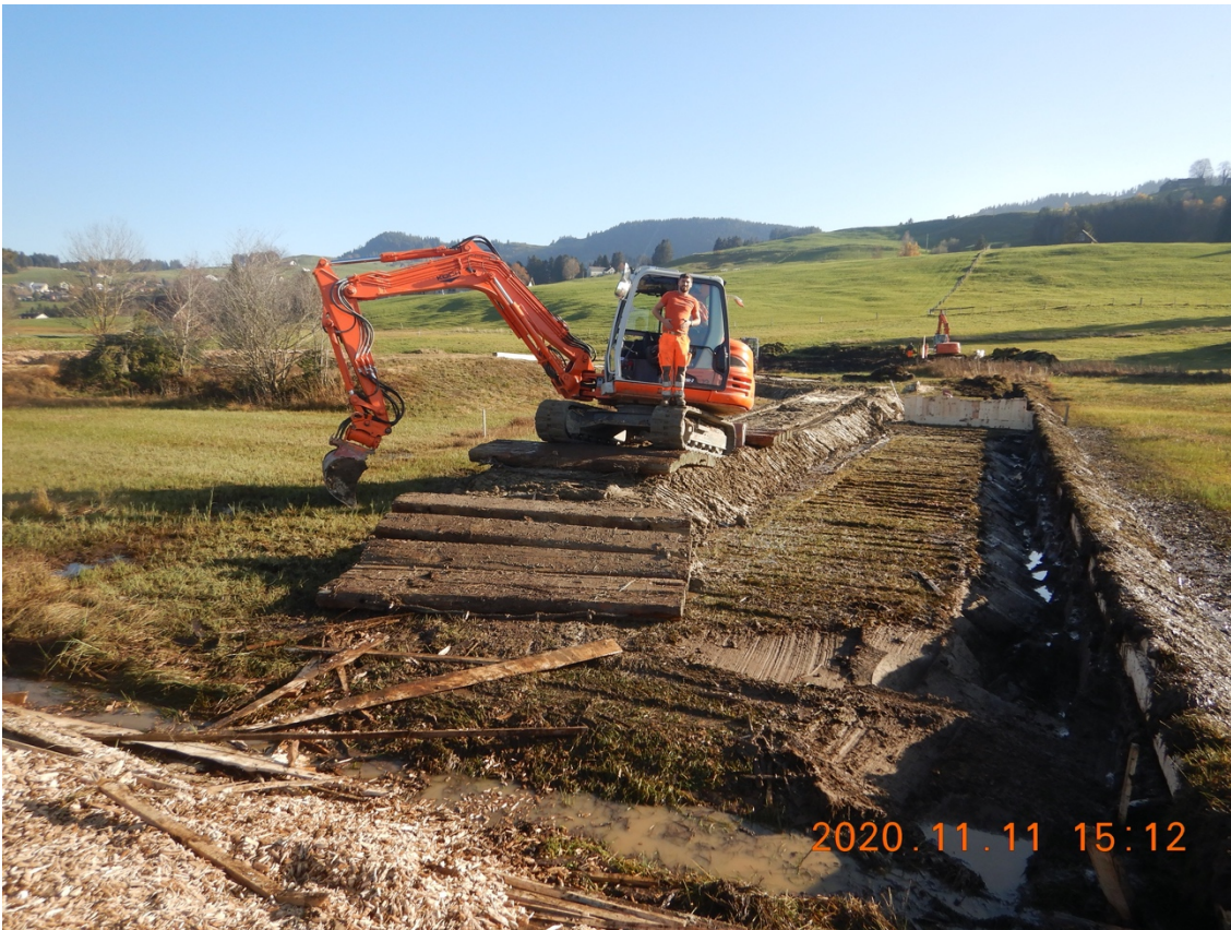
Abbildung 2 Gestaltung des Damms gegen Westen, Abtrag der Rasenziegel und Aufschüttung der zu regenerierenden Fläche.
