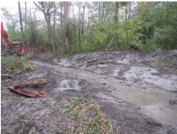
Ausbildung einer flachen, ca. 2-2.5 m breiten Mulde. Verlandungssedimente (Silt und Sand) werden direkt zu beiden Seiten angelegt (29.10.2019)
