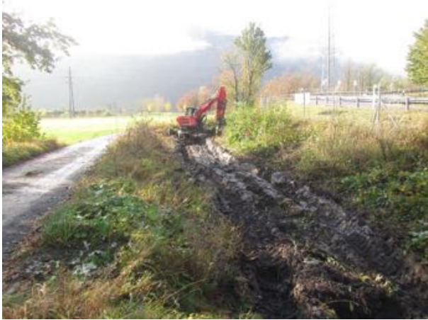
Nachgraben der stark verlandeten Verbindung zum Entsumpfungskanal im Unterlauf; Ziel: ca. 1 m breite Niederwasserrinne; Aushubmaterial (38 m 3 ) wurde auf Deponie geführt, (31.10.2019)
