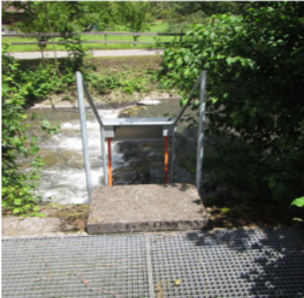
Neues Geländer beim Abgang für sicheres Arbeiten bei der seitlichen Wasserentnahme (19.06.2020)
