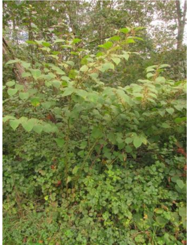
Im Rahmen der Bauarbeiten wurde ein Standort des Asiatischen Staudenknöterichs sorgfältig entfernt: Grüngut in KVA, Aushubmaterial (15.7 t) in Inertstoffdeponie Mürli AG, Walenstadt (08.10.2019)
