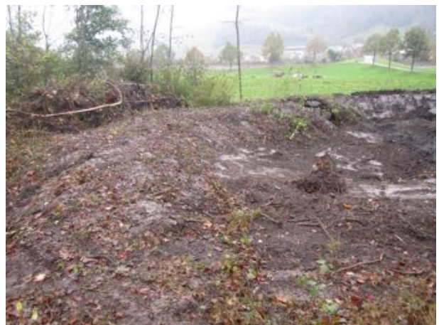
Neuer Querdamm mit Wehr im Hintergrund staut wiederum Wasser an und schafft Auenstandorte (28.10.2019)
