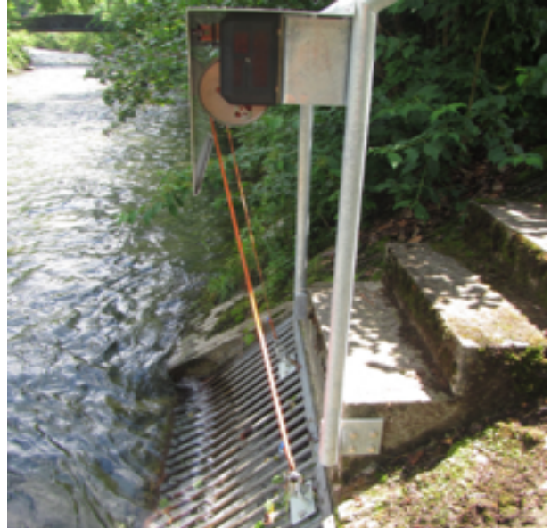
Hebevorrichtung für einfacheres Anheben des Rostes bei erhöhtem Laubanfall oder Eisbildung (19.06.2020)
