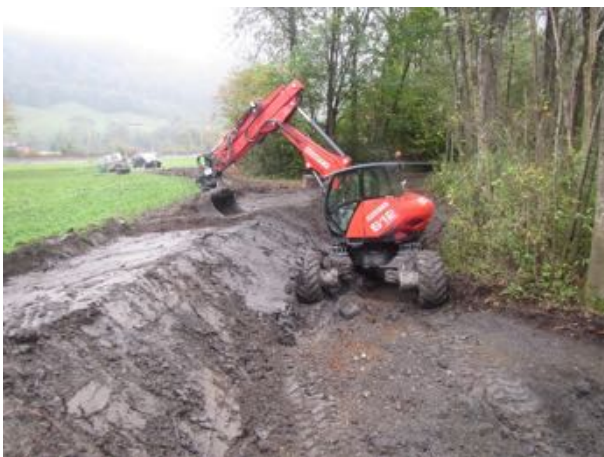
Ausbildung eines zum Landwirtschaftsland hin flach auslaufenden Dammes im neu aufgestauten Bereich durch die Marty Bauleistungen AG, Azmoos (28.10.2019)
