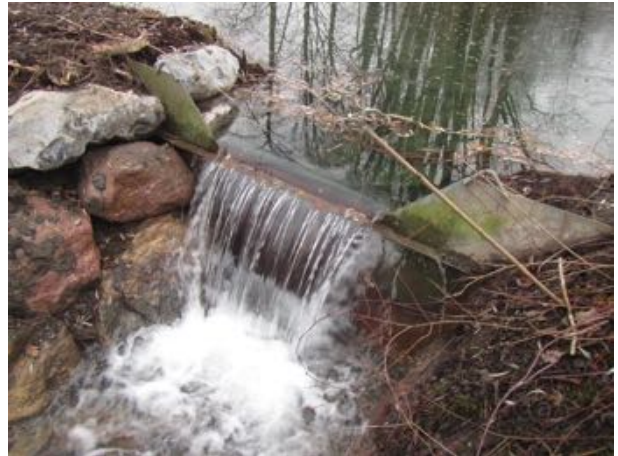
Das bestehende Wehr wurde höhengleich versetzt und mit neuen Eichenbohlen versehen (05.12.2019)
