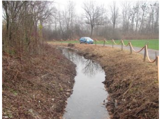
Verbindung zum Entsumpfungskanal führt wieder Wasser (05.12.2019)
