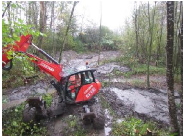
Freilegen des Zulaufs mittels Schreitbagger (29.10.2019)
