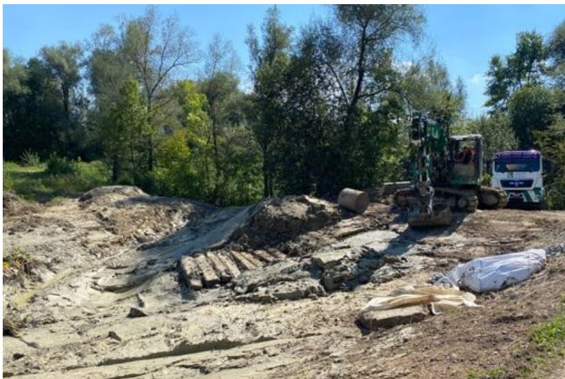
Bau des Süddammes mit Lehmkern
