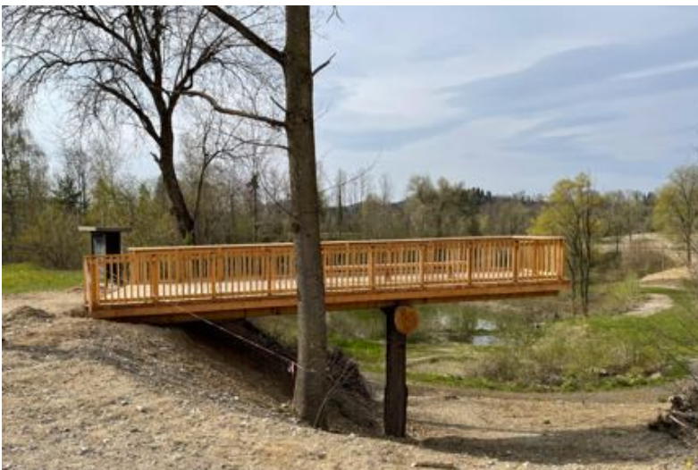
Neue Beobachtungsplattform kurz nach der Erstellung, dahinter das neue Wildbienenhotel
