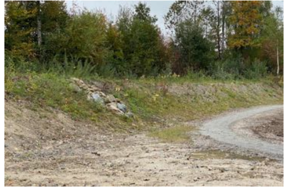
Gleiche Böschung wie links, neu gestaltet und mit neu eingebauter Steinlinse
