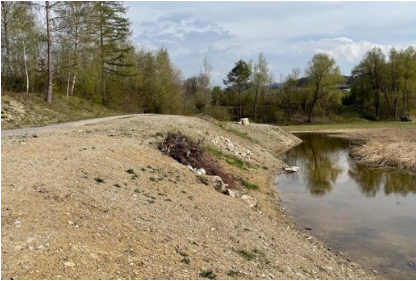
Westufer mit entlandeten Uferbereichen und neu gestalteter Böschung. Die Böschungen sind neu besser maschinell zu pflegen.
