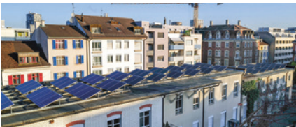
Flächen auf Gebäuden stellen ein riesiges Potenzial für Fotovoltaik-Anlagen dar: Sie müssten nur realisiert werden. (Foto: M. Sorg)
