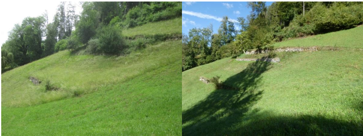
Fotos: Zustand der Trockenmauern im Jahr 2019 (links) und bei der Schlussbegehung am 8.9.2022 (rechts)
