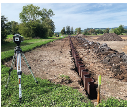
Eingebaute Vinylspundwand. (Bild 7)
