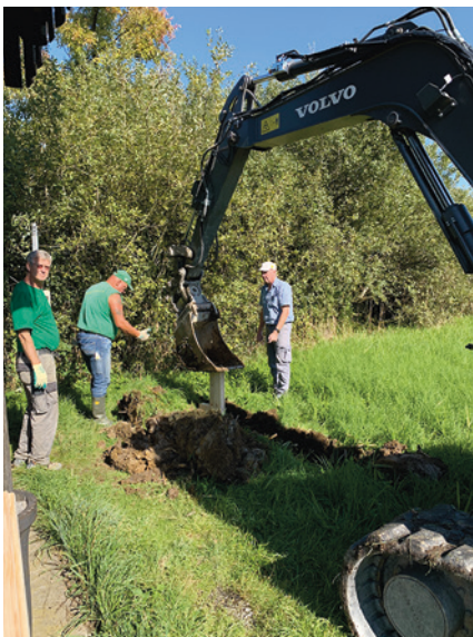
Einbau Holzspundwand für den Wasserrückhalt. (Bild 5)
