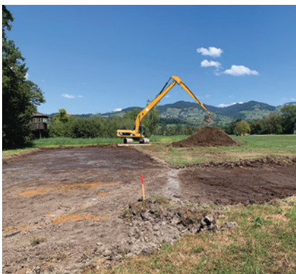
Beginn Bodenabtrag und Gestaltung Flutmulde. (Bild 6)
