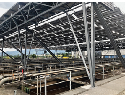
So gelingt die Energiewende: Klärbecken mit einer Fotovoltaikanlage überdacht (Abwasserverband Morgental, Steinach). (Bild 4: P. Bendel)
