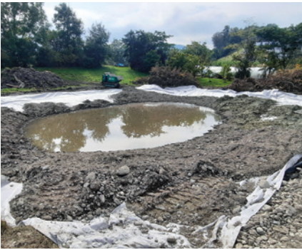
Die Folie wurde mit einem Schutzvlies und nährstoffarmem Wandkies überdeckt. (Foto: Pro Natura St. Gallen-Appenzell)
