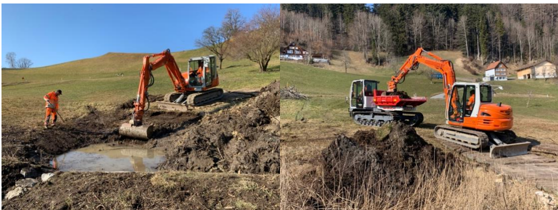
Abb. 4/5: Aushub Weihermulde mit Flachwasserzone (links) und Abtransport (rechts)
